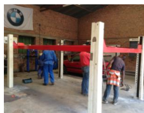
Nieuwe hefbrug in opbouw
